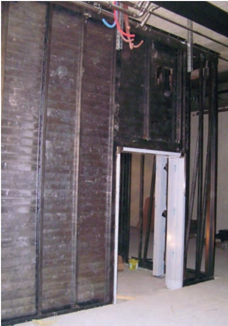
Strahlenschutz mit Bleisteinen (hier mit 28 mm Pb)
